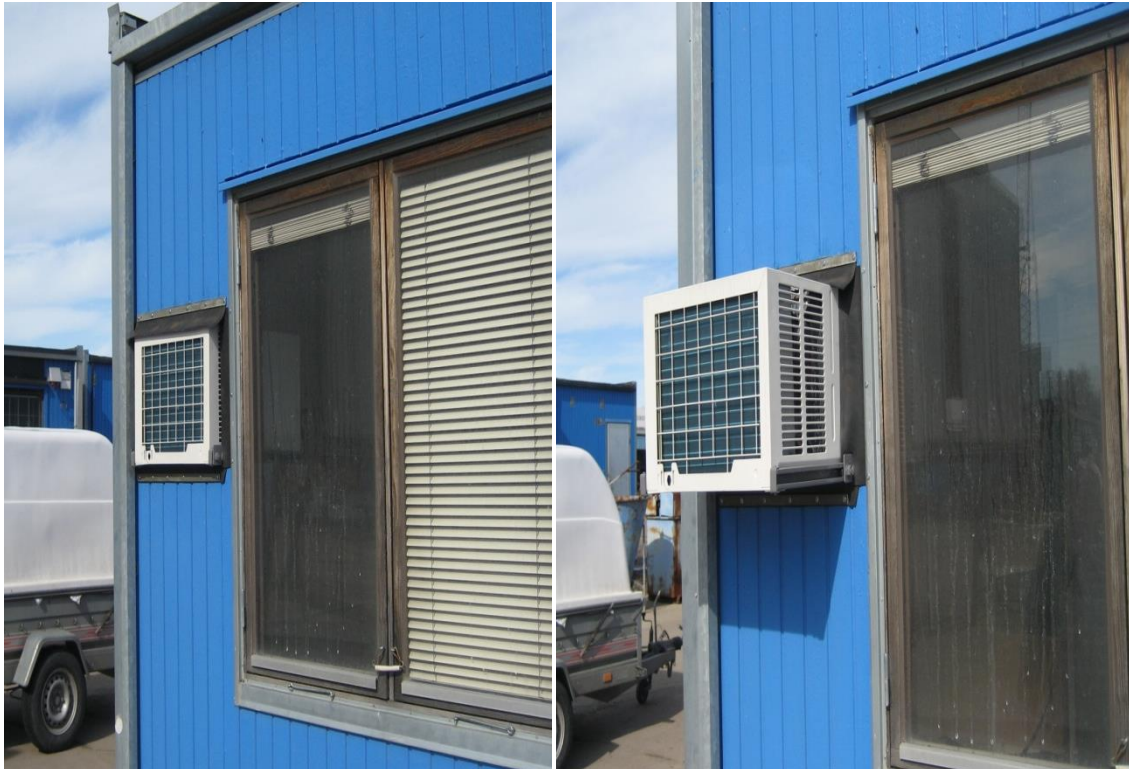
Bild 3. Montagealternativ 3 montage på kortsida av bod.
