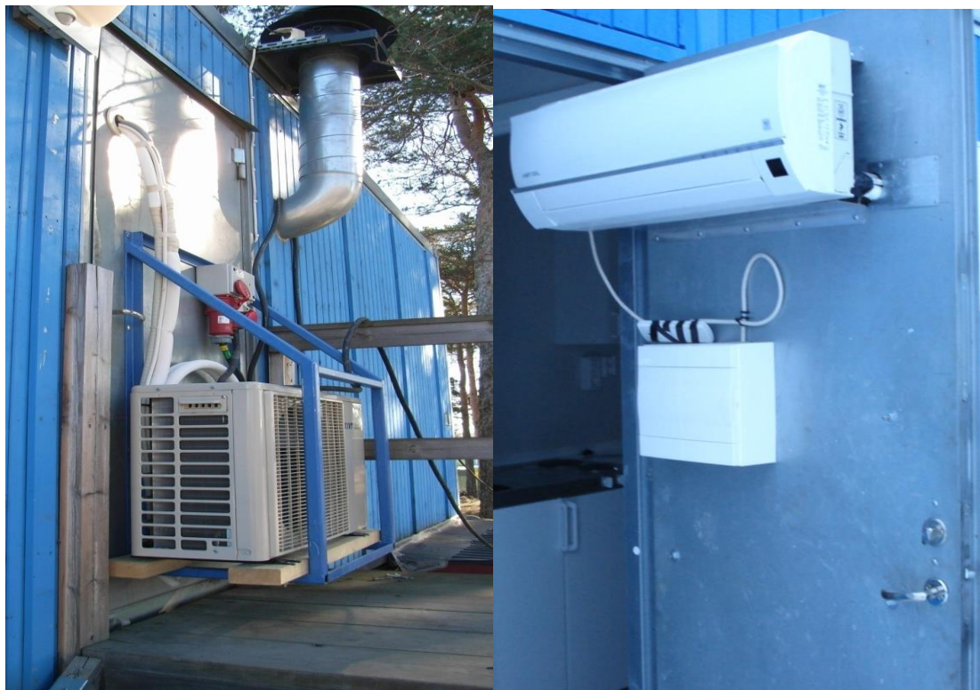
Bild 1. Montagealternativ 1 dörrmontage på bods långsida – utsida t.v., insida t.h.
